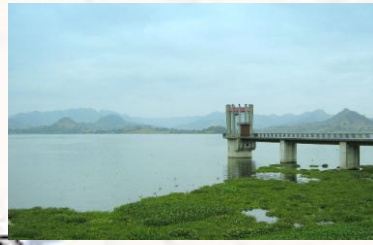
ESTACIÓN DE BOMBEO LA ESPERANZA
