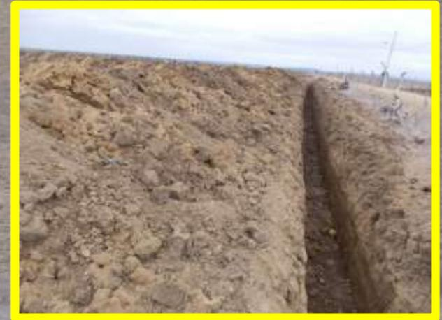
Foto N°8. Se va a instalar la tubería para drenaje. subterráneo
