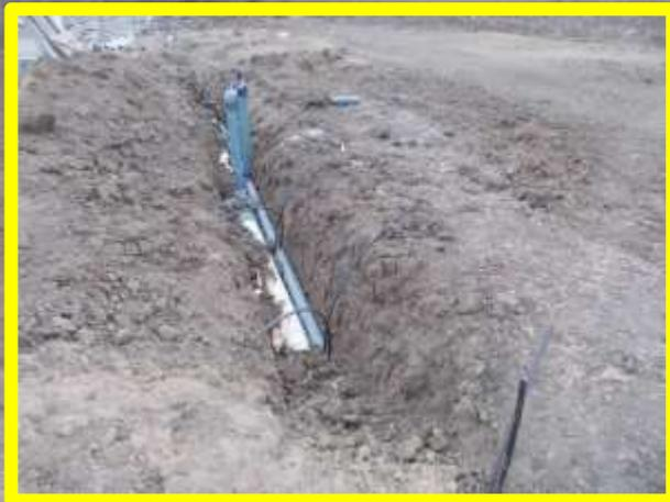
Foto N°7. Tubería para el riego.
